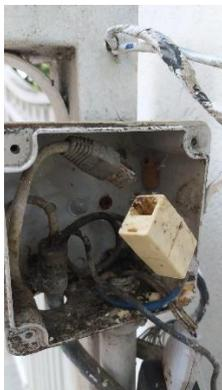
Na verificação dos racks localizados nos subsolos onde estão instalados os switches de distribuição das torres, temos equipamentos superaquecendo devido à falta de refrigeração e equipamentos amontoados, também erro na fixação, equipamentos que apresentam falhas e mal contato.
